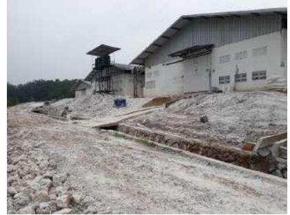
Pemasangan kapur di seluruh area kandang
