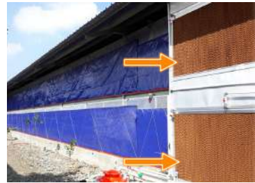
Cooling pad sebagai bagian dari sistem ventilasi Closed House
